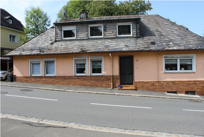
Weißensteinstraße Hs.-Nr.12, Nivellierung der Oberflächen sind in der Sockelzone des Gebäudes lesbar.
