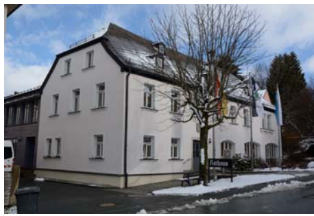
Denkmal Rathausstraße 7 (Rathaus): 1850 genehmigte die Regierung den Kauf des westlichen Teils durch die Marktgemeinde, weil man dringend einen Versammlungsraum, eine Wohnung für den Gemeindediener und eine Remise für die Feuerlöschmaschine benötigte.
