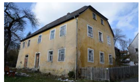
Denkmal Bahnhofstraße 21: Über der Haustür findet sich im Keilstein eine stark abgewitterte Inschrift „JNB“ (Johann Nikolaus Baumann) und wohl die Jahreszahl (1)80(1). Bemerkenswert sind die zweiflügelige Füllungstür im Haupteingang und mehrere historische Fenster, u. a. Kreuzstockfenster mit Vorreiberverschluss wohl noch aus dem 19. Jahrhundert.
