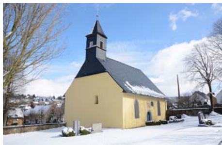
Denkmal Friedhofstraße 16: In Stambach war die Anlage und der Bau einer ersten Friedhofskapelle 1561 vollendet. Daran erinnert eine Inschriftentafel über dem Südportal („Nach Christi unsers herrn geburt 1557 ist dieser Gottesacker in d(e)m grossen sterben zuerbawen angefangen und inn dem 611(e)n volendet“).
