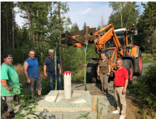
Der 3-Landkreis-Stein wird gesetzt Neue Landmarke am Qualitätswanderweg Fränkisches-Steinreich entsteht
