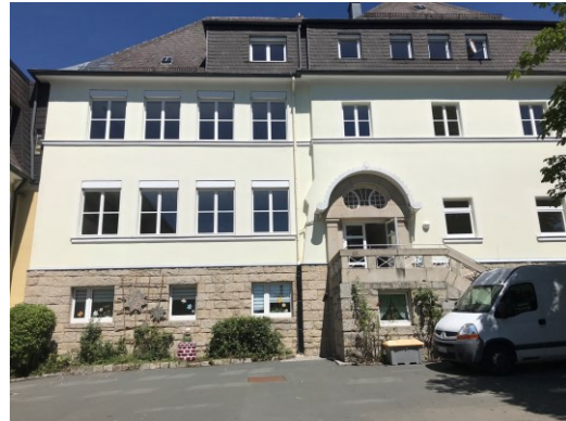
Neue Fenster für die Schule
