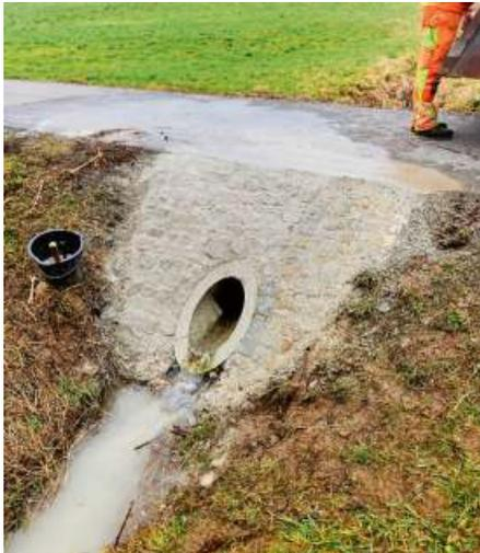
Durchlass mit Pflastersteinen versehen nach Ausspülung durch Starkregen.
