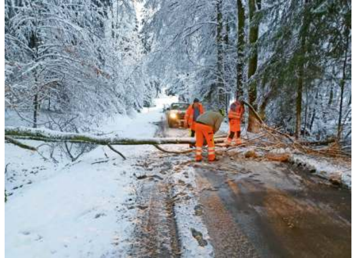
Beseitigen von Schneebruch an Gemeindestraßen.
