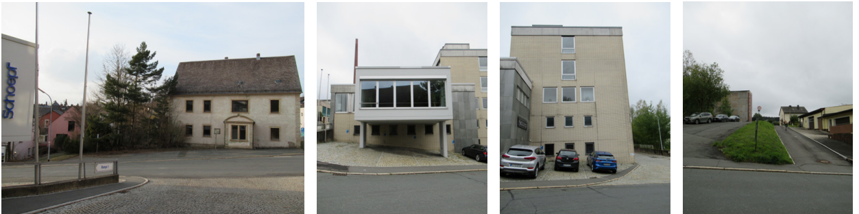
Foto-Aufnahmen Bestandssituation Firma Schoepf / Rathausstraße
