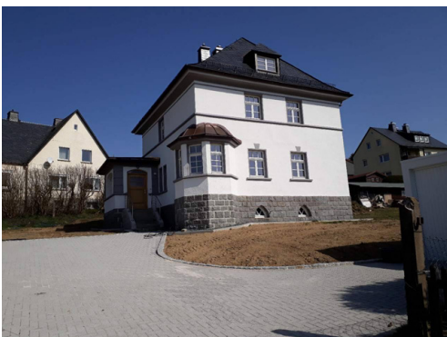
Abb. 21 Saniertes Gebäude, Durchgeführt durch die Villa Schmidt-Stiftung
